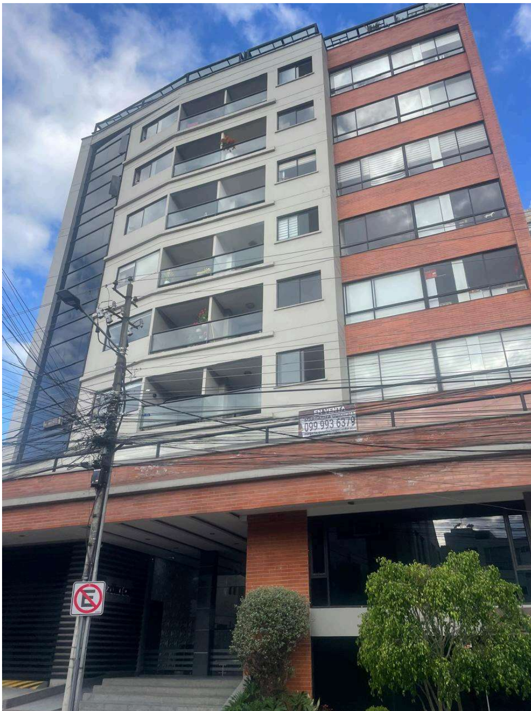
ECUADOR. En el edificio declarado como domicilio por la empresa Karamba, el guardia de seguridad señaló que allí no funciona ninguna oficina con ese nombre.
